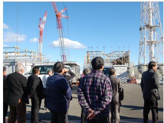
12日撮影。超高濃度汚染された排気塔(右)は倒壊リスクがあるため、半分の高さに切り下げ中。爆発した1号機(中央)を俯瞰する高台は、空間線量36~100マイクロシーベルト。藤沢市の1000~2500倍程度の高濃度空間です。
